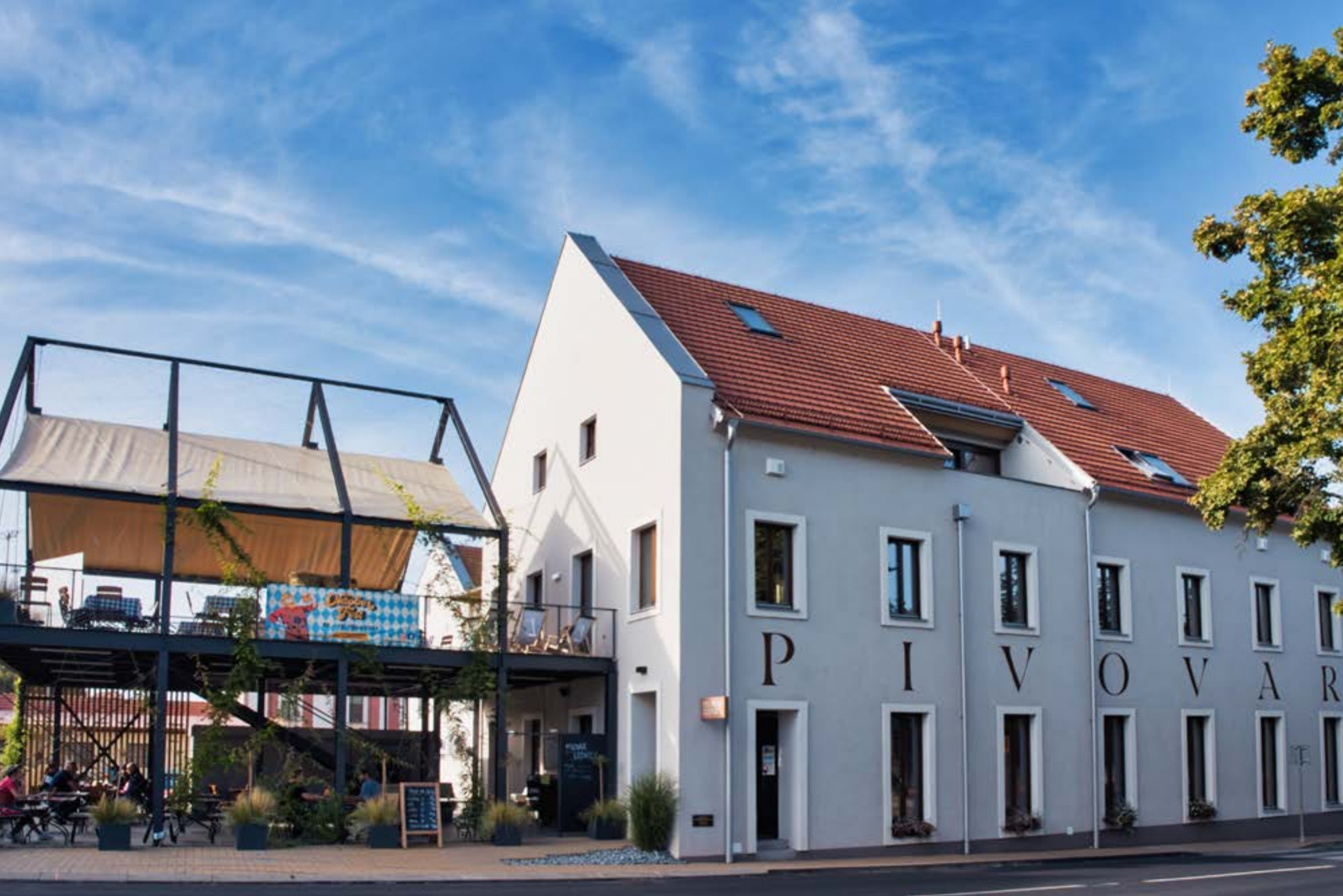
Pohled na dokončenou stavbu včetně dvoupatrové terasy, která signifikantně kopíruje tvar budovy pivovaru.
